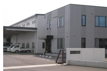
宝建設（株） イタリヤード本社社屋新築電気設備工事 平成2年7月竣工 請負額/72,900千円
