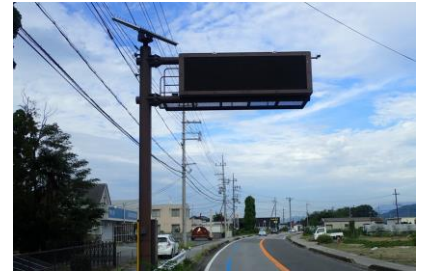
交通安全施設 交通車線変移システム設置工事
