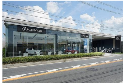
トヨタ T&S 建設㈱ レクサス宇治改修工事 令和 1 年 8 月竣工 請負額/34,560 千円
