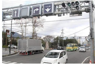
交通安全施設 道路情報表示機設置工事
