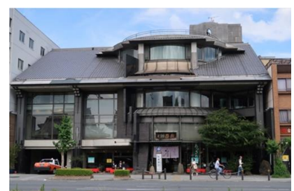
大成建設 (株) (株) 西利 本店 新築電気設備工事 平成 2 年 8 月竣工 請負額/42,930 千円
