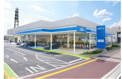
大和ハウス (株) ネットヨタヤサカ (株) 桂川店新築工事 平成 16 年 8 月竣工 請負額/35,964 千円
