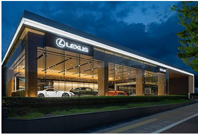
トヨタ T&S 建設㈱ レクサス北大路改修工事 令和 2 年 9 月竣工 請負額/43,450 千円
