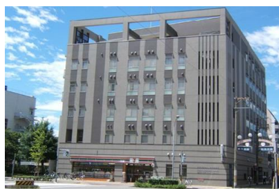
イワモトエンジニアリング（株） 介護施設じゅんぼう新築電気設備工事 平成17年4月竣工 請負額/70,350千円
