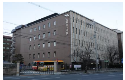
(株) 鴻池組 光華学園 70 周年記念棟新築工事 平成 22 年 12 月竣工 請負額/138,000 千円
