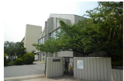
(株) 松村組 神足小学校・保育園等複合化施設工事 平成 28 年 3 月竣工 請負額/145,800 千円
