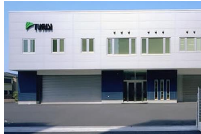
(株)大林組 (株) 筑紫本社及び工場新築電気設備工事 平成 18 年 6 月竣工 請負額/45,150 千円
