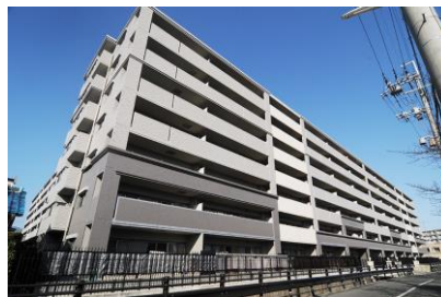
東海興業（株） エスリード三条天神川新築工事 平成19年8月竣工 請負額/203,000千円
