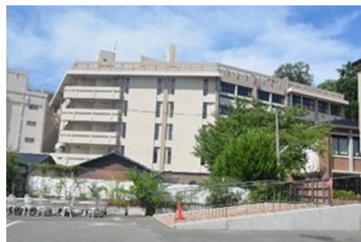
西松建設㈱ 京都女子大学 C 校舎耐震補強改修工事 平成 25 年 5 月竣工 請負額/95,550 千円
