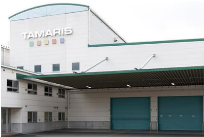
(有)ヨシオカ 大阪タマリス事務所改装工事 平成 19 年 12 月竣工 請負額/22,00 千円
