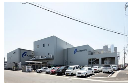
太平工業 (株) (株) 五健堂本社総合物流センター新築工事 平成 19 年 10 月竣工 請負額/40,500 千円
