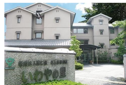
横田建設（株） 老人保健施設いわやの里新築電気設備工事 平成10年11月竣工 請負額/103,950千円
