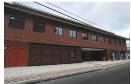
西松建設㈱ 京都女子大学 K 校舎耐震補強等工事 平成 26 年 3 月竣工 請負額/26,250 千円
