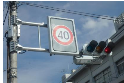
交通安全施設 可変式標識設備設置工事
