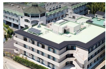
（株）ツバサ工務店 旭ヶ丘老人ホーム増設電気設備工事 平成4年2月竣工 請負額/42,230千円
