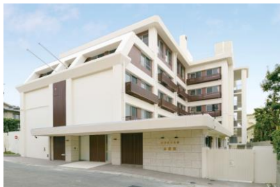
西松建設㈱ 京都女子大学小松寮耐震工事 平成 28 年 3 月竣工 請負額/81,000 千円
