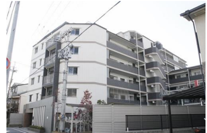
東海興業（株） 山科左義長町マンション計画新築工事 平成20年3月竣工 請負額/46,800千円
