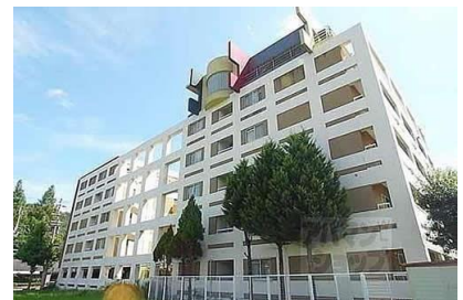
（株）大林組 大晋メジネ北山通り新築電気設備工事 平成10年8月竣工 請負額/26,145千円
