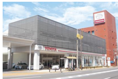
(株) 大林組 京都トヨタ自動車 (株) 本社店新築工事 平成 19 年 10 月竣工 請負額/43,400 千円
