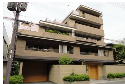
（株）大林組 グランエスパス御所東新築電気設備工事 平成19年8月竣工 請負額/26,000千円
