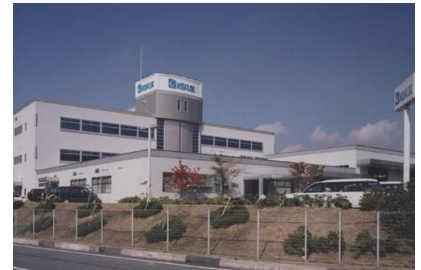
(株)大林組 コフロック (株) 宇治田原電気設備工事 平成 10 年 11 月竣工 請負額/117,600 千円
