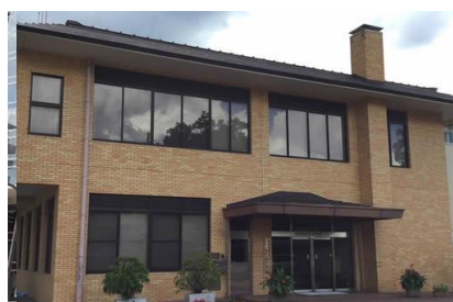
京都府きんでん 南丹野原農具製作所電気設備工事 昭和三十九年 11 月竣工 請負額/38,000 千円 (当社 195,300 千円)
