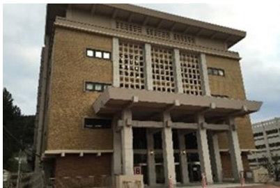
西松建設㈱ 京都女子大学 B 校舎耐震補強等工事 平成 26 年 3 月竣工 請負額/257,775 千円
