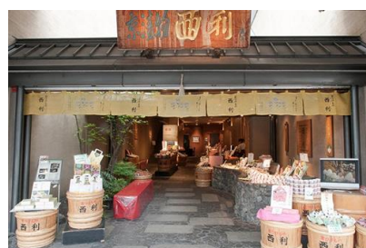
大成建設 (株) (株) 西利 祇園店 新築電気設備工事 平成 9 年 3 月竣工 請負額/18,170 千円
