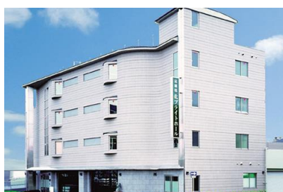
(株) 藤井組 公益社北ブライトホール新築工事 平成 11 年 12 月竣工 請負額/63,840 千円
