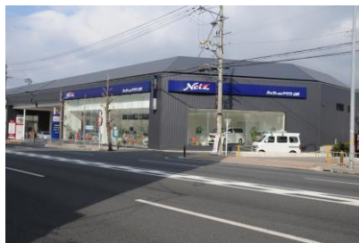
鹿島建設㈱ ネットヨタヤサカ (株) 山科店新築工事 平成 22 年 1 月竣工 請負額/20,350 千円
